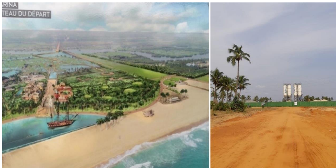
↑ À gauche, Image reproduisant le projet de Marina à Ouidah. ©Ministère du Tourisme À droite, le chantier de construction de la Marina, en janvier 2023. ©Amnesty International
